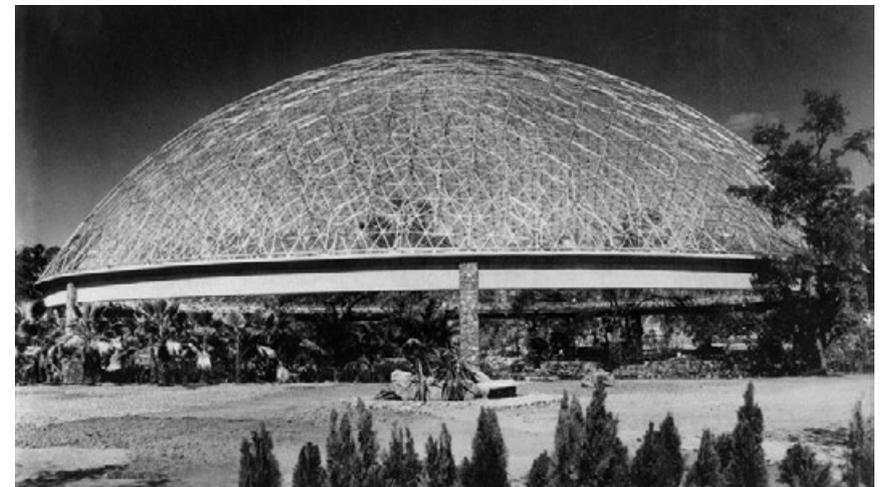
Richard Buckminster Fuller, diseñó la cúpula geodésica del Centro Vacacional del IMSS en Oaxtepec. Juan Becerra y Manuel Teja diseñaron y aplicaron un sistema propio, con piezas de acuerdo a su diseño, con materiales fabricados por ellos para su construcción. Esta cúpula aún continúa en operación
